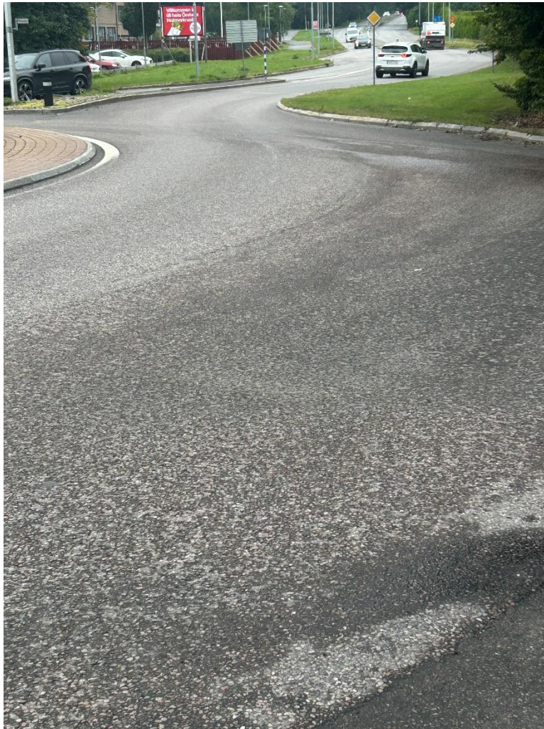
Figur 3 Vintrosarondellen med ABS-asfalt som slitlager, Örebro.
